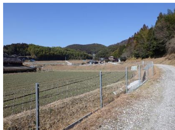
鳥獣侵入防止柵の設置
