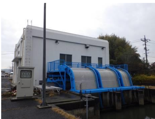
排水機場の機能保全対策
