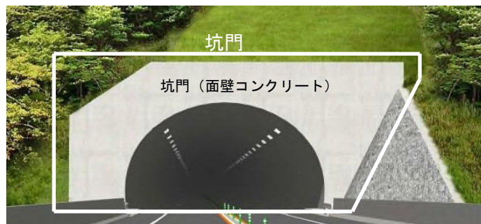
図 1-3 点検対象箇所（トンネル坑口部）
