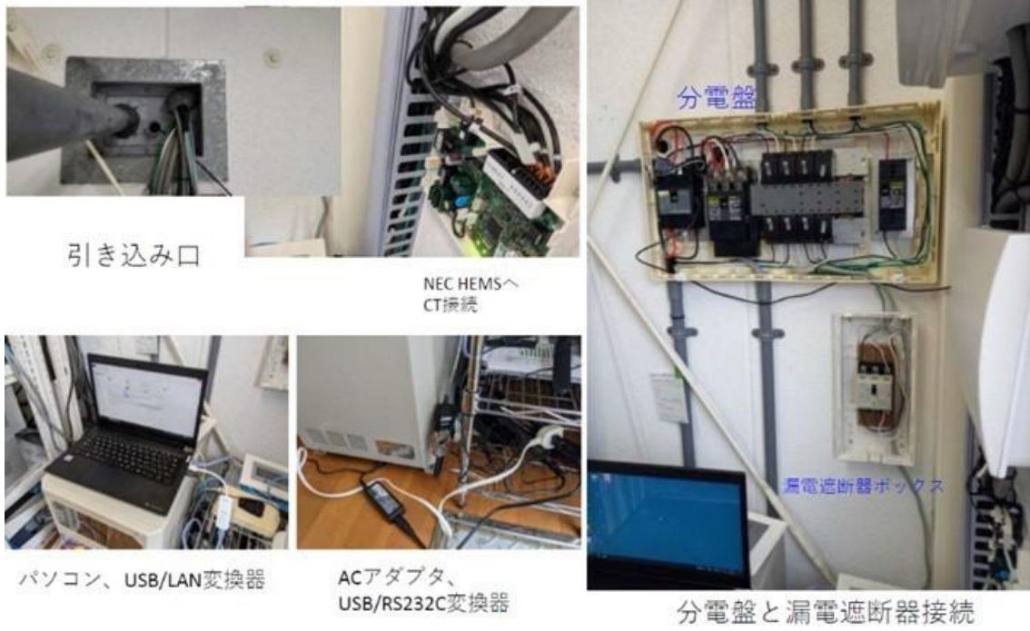
図 3-2-3 工事内容（大気測定局舎内部）
