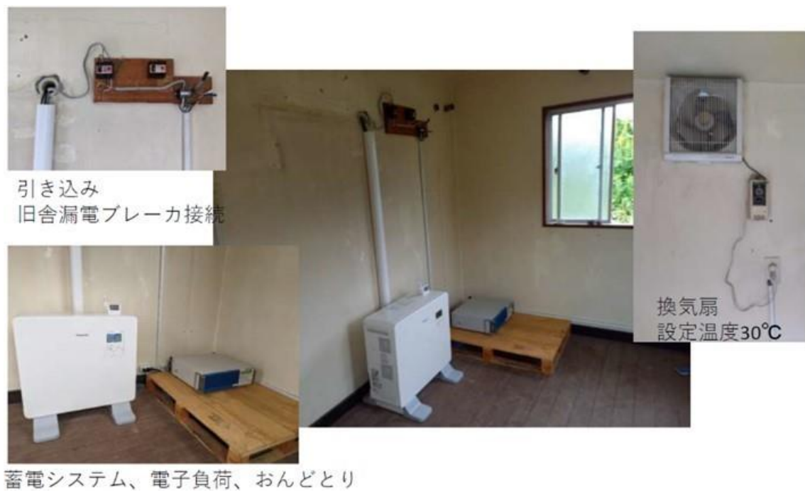
図 3-2-4 工事内容（旧舎内部）
