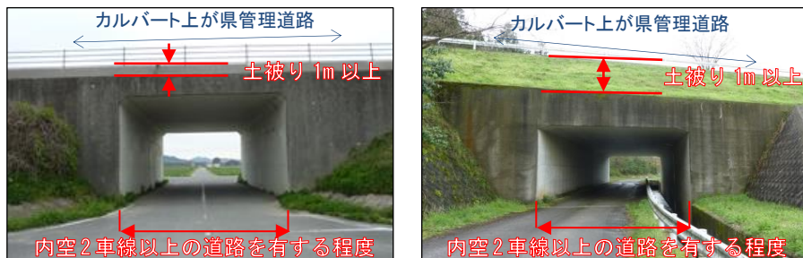
<大型カルバートの例>
