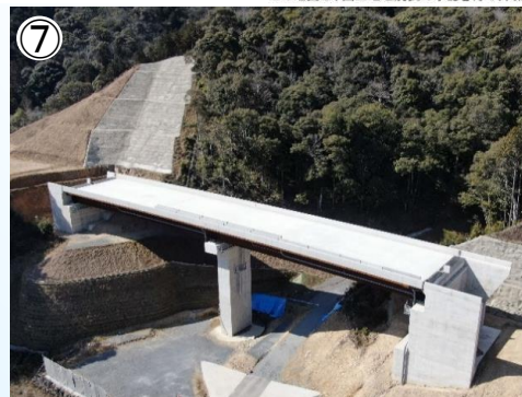
⑦ 9号橋の状況
