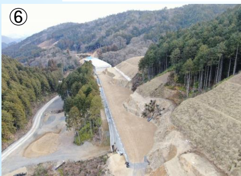
⑥ 4号橋付近の状況
