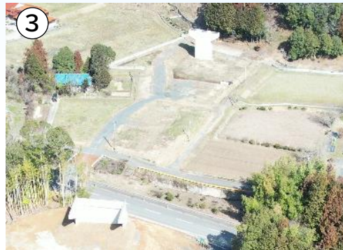
③ 2号橋の施工状況
