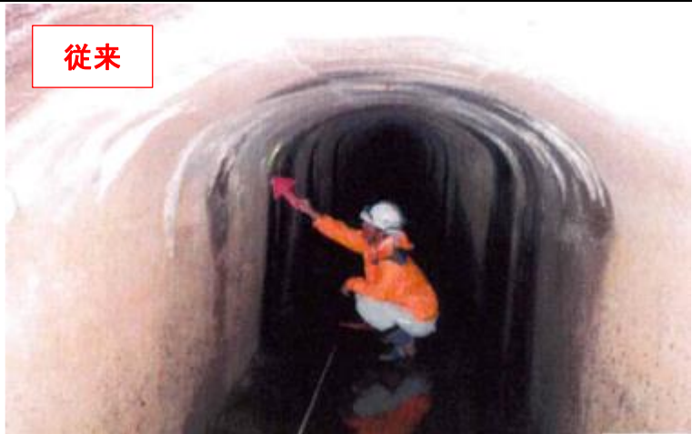
《水抜きを行い、点検者による目視点検》
