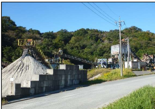
がれき類リサイクル施設
