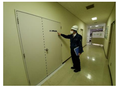
▲ 備蓄倉庫の様子
