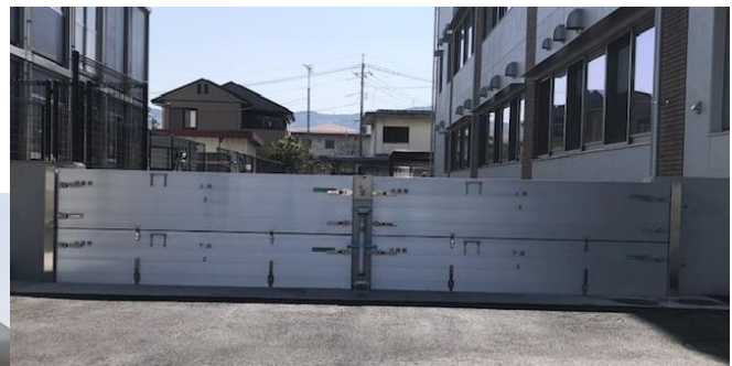
庁舎への浸水を防ぐ止水板を整備
