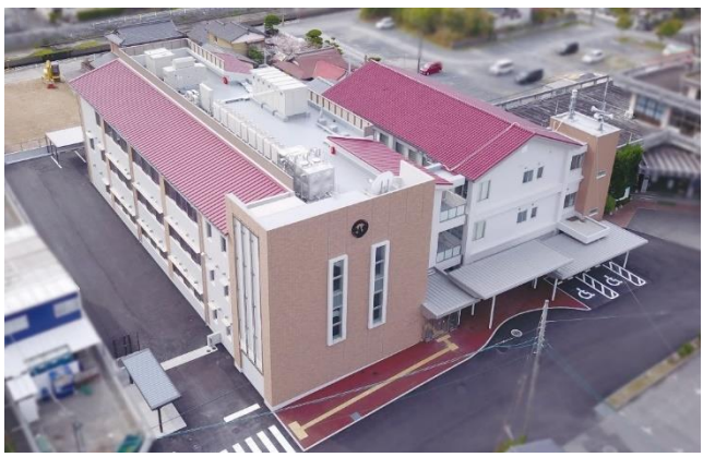
新庁舎における水害対策
