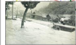
昭和29年9月洞爺丸台風 浸水状況
