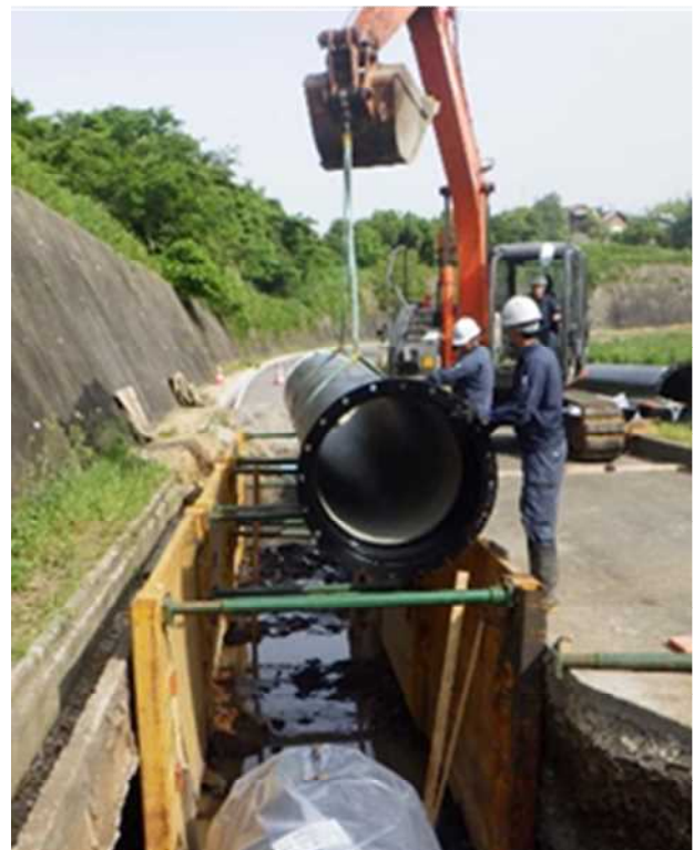
開削工施工中の状況
