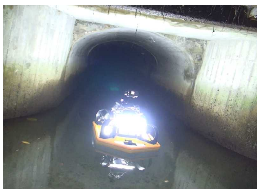
【通水状態での点検状況（試作機）】
