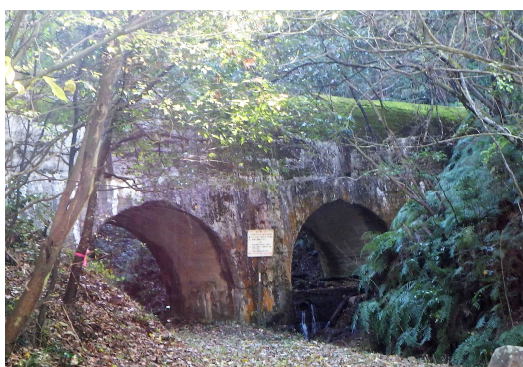
第1号水路橋の現況 [厚東川工業用水道]
