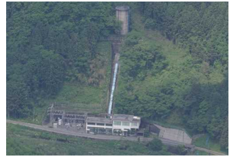
《佐波川発電所》
