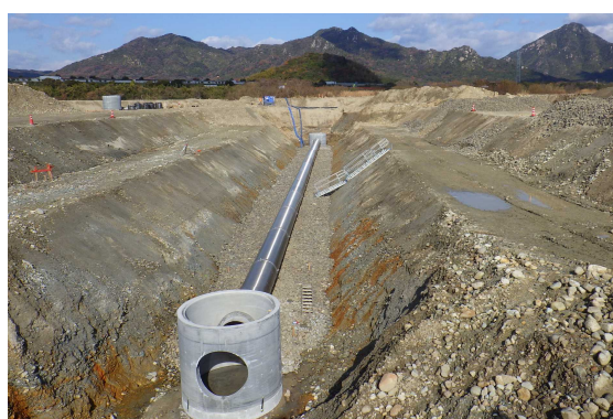
巻線形スクリーン管布設 [佐波川工業用水道]
