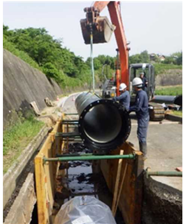
開削工施工中の状況
