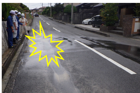
漏水発生箇所周辺の計画的な管路更新
