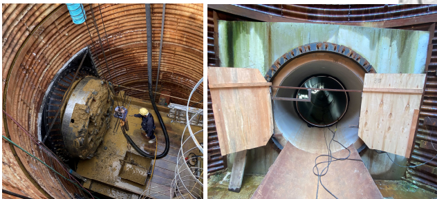
推進工施工中の状況(φ2000HP) (工事計画)
