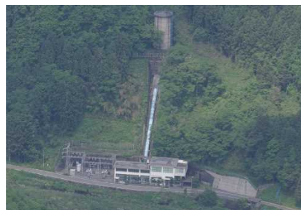
《佐波川発電所》
