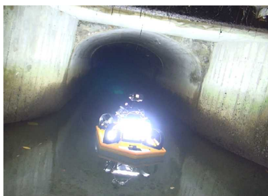
【通水状態での点検状況（試作機）】
