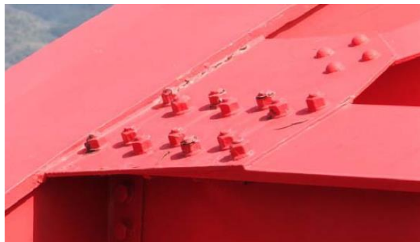
アーチリブ継手写真（２） リベット構造（一部）
