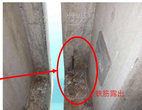
【ヒンジ部漏水による損傷イメージ】
