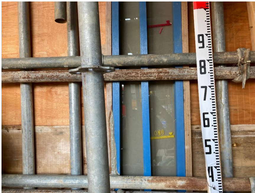
透明型枠（クリアパネル）の設置
