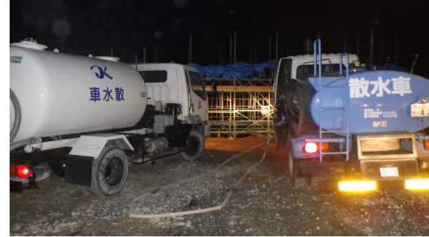
散水車による水の供給
