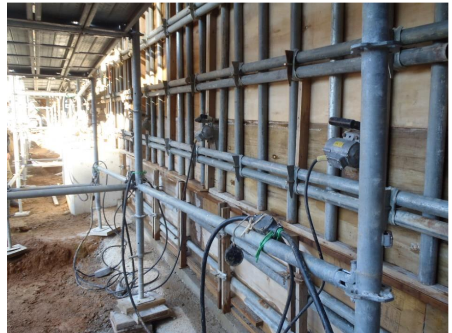
型枠バイブの使用
