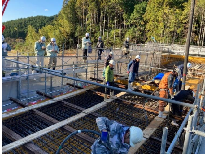
施工状況把握研修
