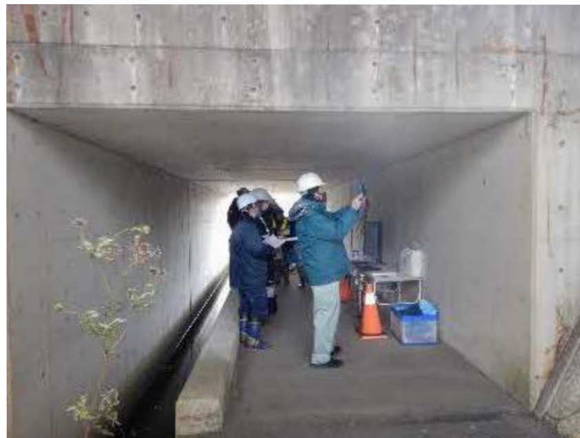
点検記録自動作成アプリ等の現場試行状況
