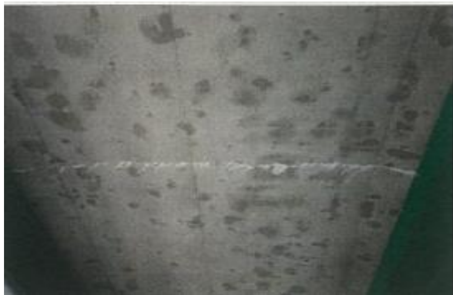
新気仙大橋のRC床版下面 (一部はエフロレッセンスが確認, 自己治癒現象とも見える)
