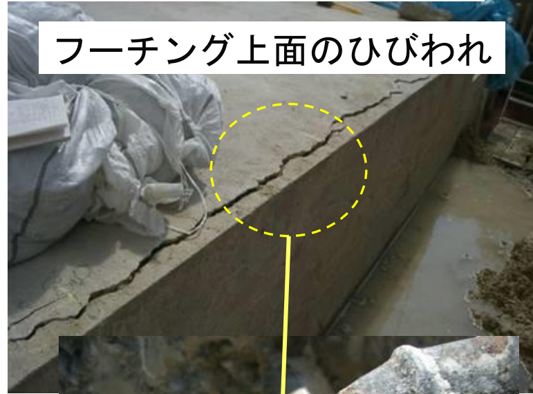
フーチング側面のひびわれ
