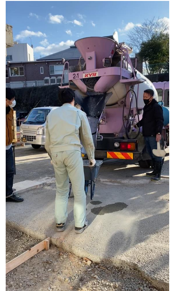
造粒材を添加後、 現場に運搬して打設
