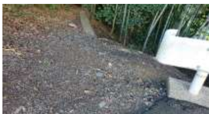
国道につながる道路沿いの斜面
