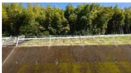
本校北側の法面
