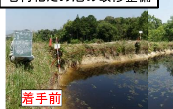
老朽化ため池の改修整備
