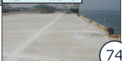
岸壁エプロン打替え後
