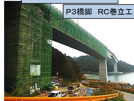
彦島大橋 耐震補強
