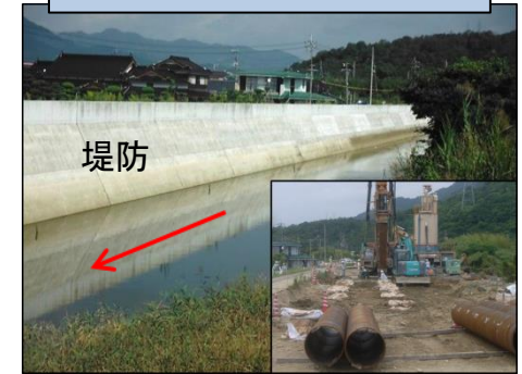
横曽根川 堤防の耐震化
