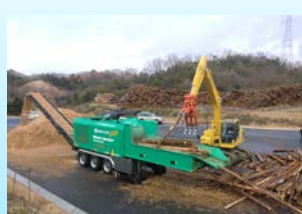
バイオマスセンター
