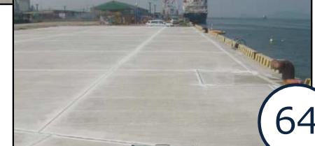
岸壁エプロン打替え後
