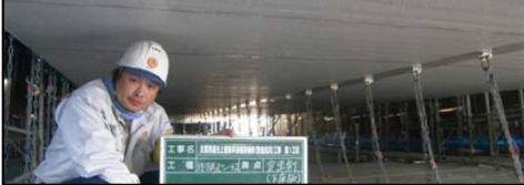
補修後 断面修復工+剥落防止工
