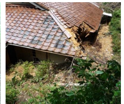
急傾斜地崩壊対策事業（中畑地区）
