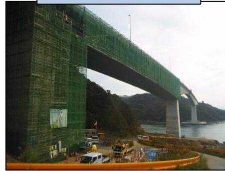
彦島大橋 耐震補強
