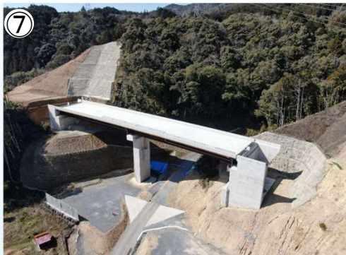
9号橋の完成状況
