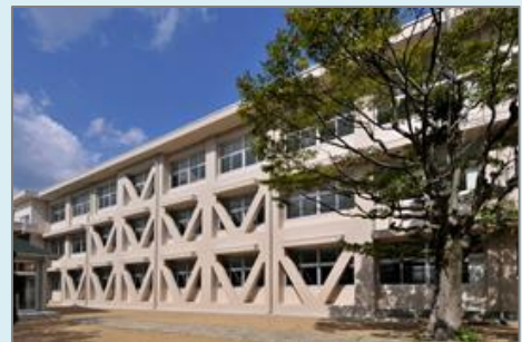
○耐震改修（大津緑洋高校）
