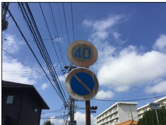
標識板の退色
