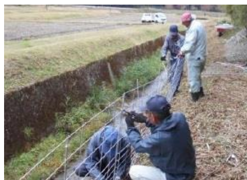
防護柵の点検・補修作業 （下関市 阿座上集落協定）
