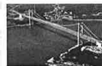
関門橋 開 通：S48.11(47年経過) 交通量：30,900台/日(R2)
