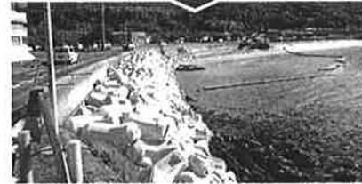
設置された消波ブロック
