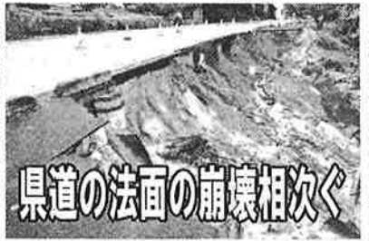
県道小野田美東線(吉部地区)の現場
