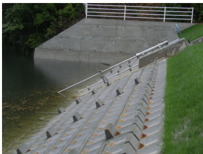
法面を這い上がりやすい張ブロック (防災型) の設置
