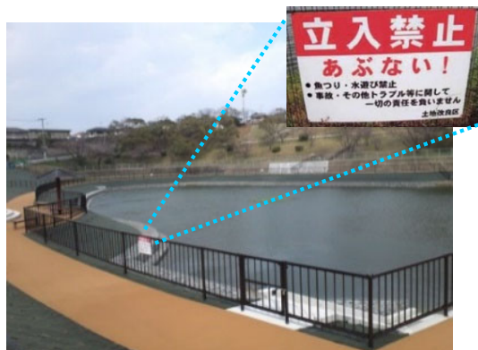
転落防護柵と警告看板の設置
