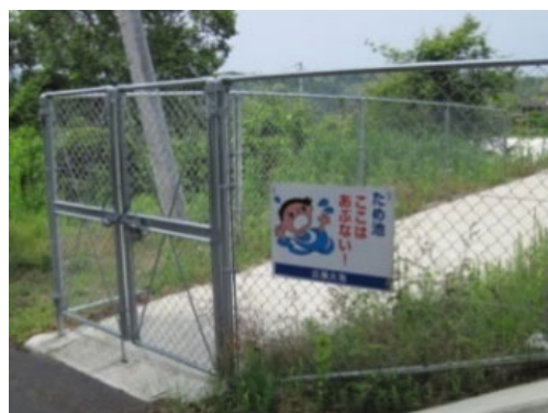
進入防止フェンスの設置
