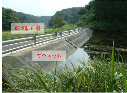
堤体法面に設置した安全ネット
