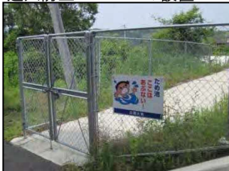
進入防止フェンスの設置
