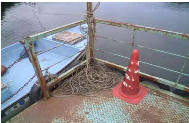
救出用安全ロープの常時設置
