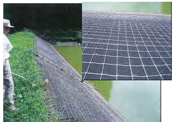
安全ネットの設置
