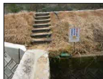
警告看板の設置
