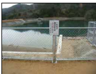
警告看板の設置
