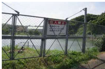
転落防止柵・警告看板の設置
