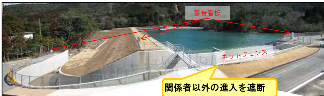
転落防止柵の設置
