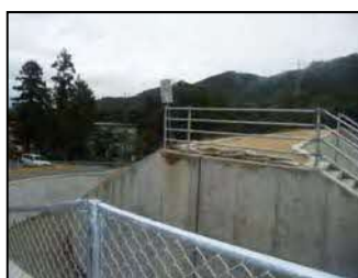
警告看板の設置
