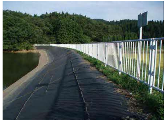
堤体法面に安全ロープの設置
