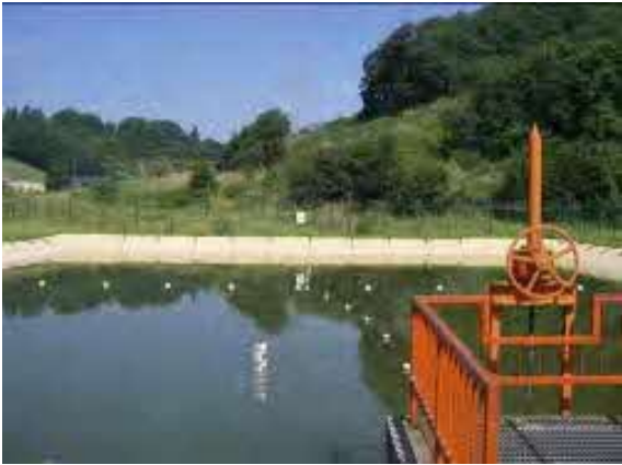
水面上に十字形に池内ロープの設置
