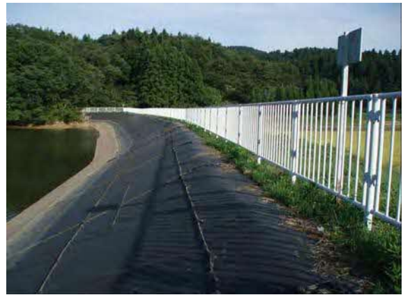
堤体法面に安全ロープの設置
