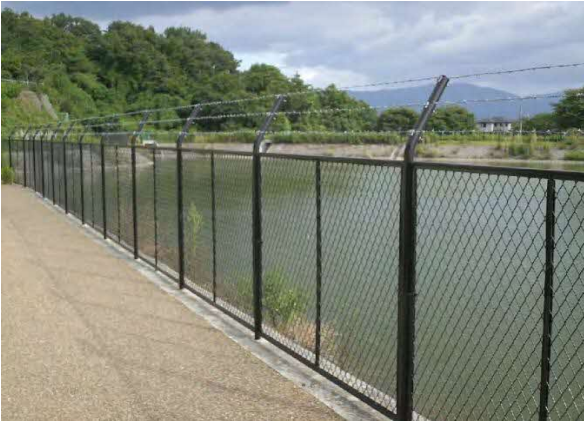
防護柵の設置
