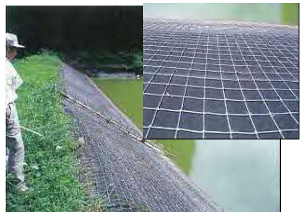
安全ネットの設置
