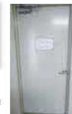
ドアノブの改修(レバー型に変更)
