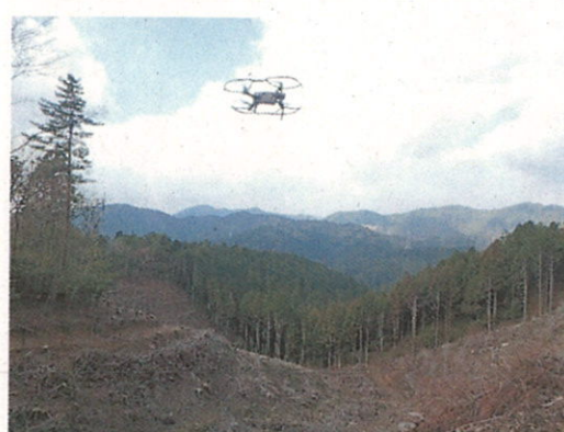
ドローンによる現場管理
