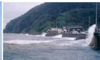
平成16年 台風18号での越波状況
