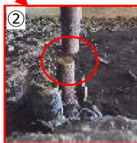
《写真①②》鉛直 P C 鋼棒の破断が目視で確認できたもの
