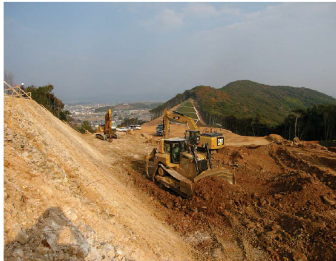
掘削(切土)施工中
