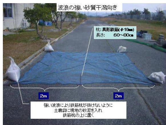
図5 鉄筋杭と土嚢による網の設置
