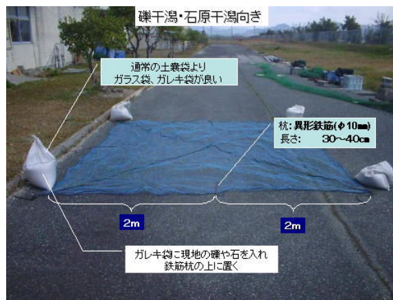
図6 短い鉄筋杭とガレキ袋による網の設置
