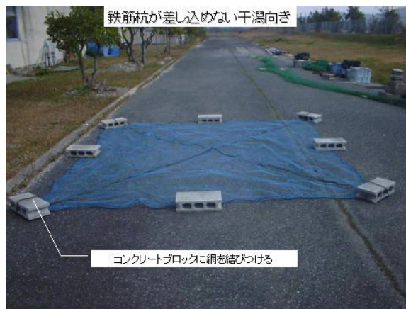
図7 コンクリートブロックによる網の設置
