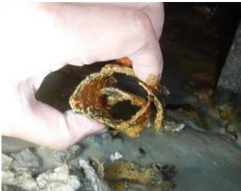
鉛直PC鋼棒⑫下部工側(防錆処理)
