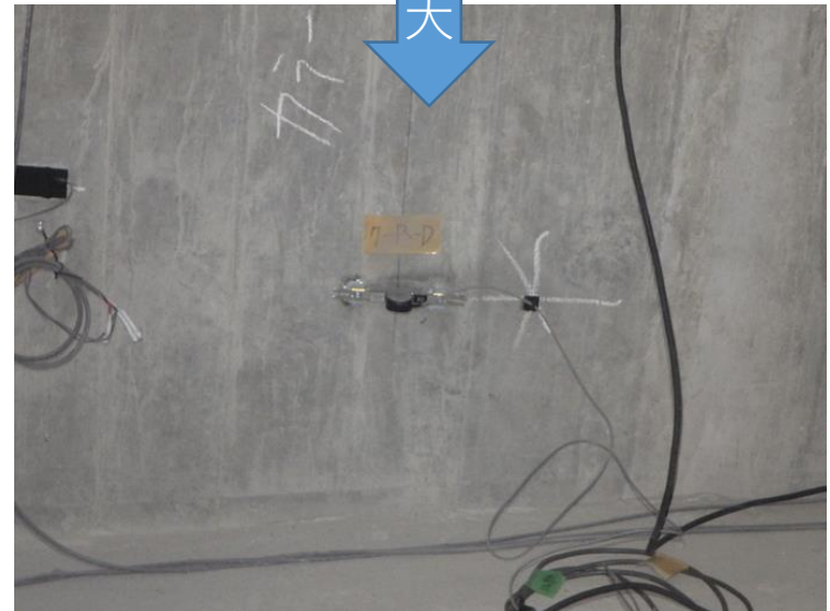
箱桁内部ひずみゲージ
