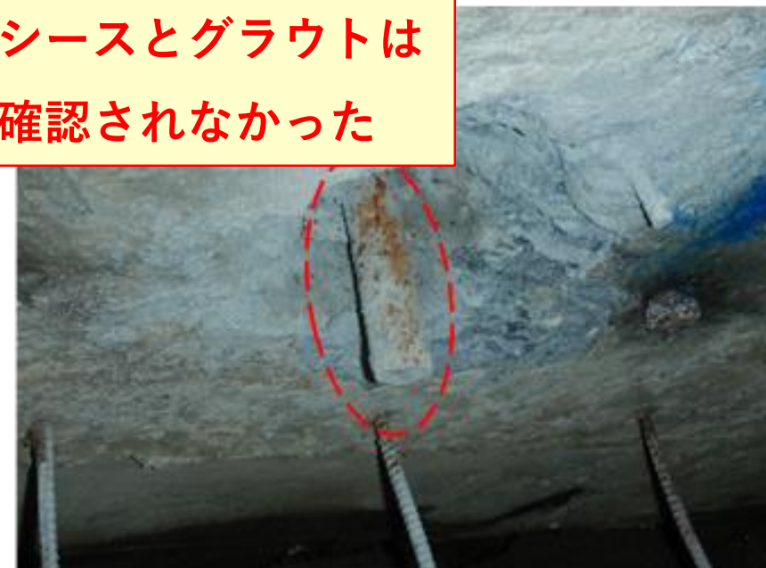
鉛直PC鋼棒⑫上部工側
