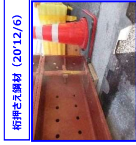
【桁押さえ部の状況】 ・緩衝ゴムとH鋼の隙間: 1~2mm
