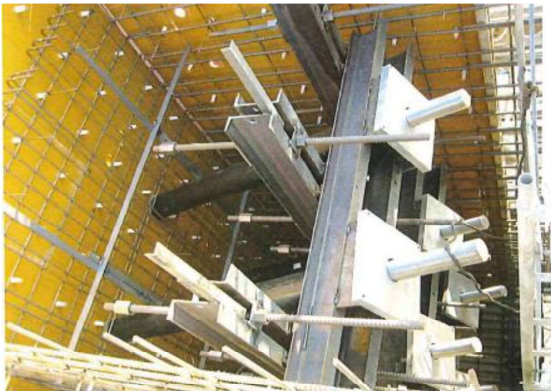
③グラウンドアンカー設置工
