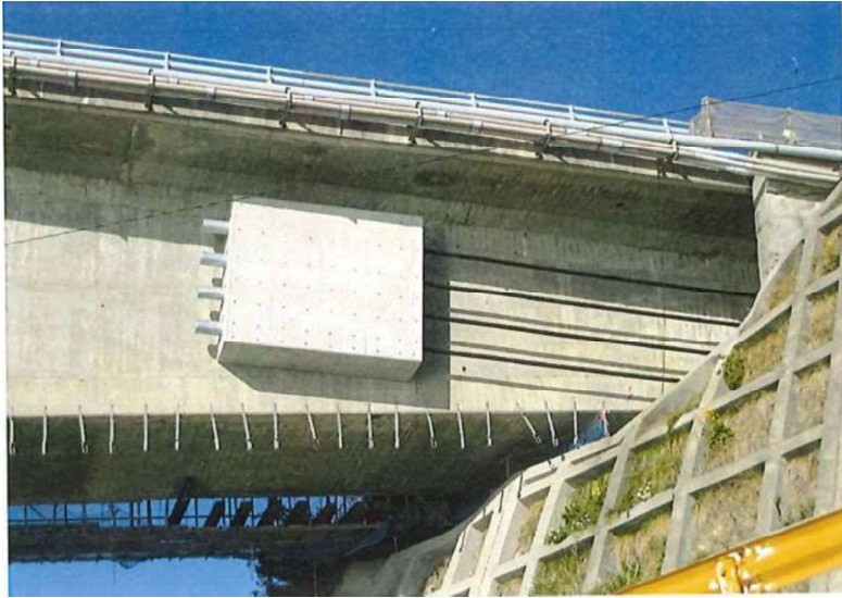
②主桁橋台連結工(室津東側)
