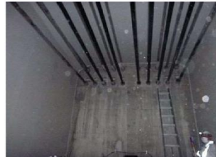
⑩隔壁、PC貫通孔状況
