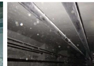
⑤PC鋼材、上面状況
