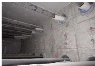
⑨隔壁1 PC貫通孔状況
