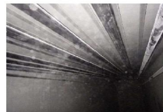
④PC鋼材状況
