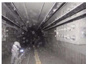
⑬ 内空状況
