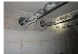
④PC貫通孔、壁面状況
