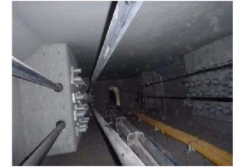
②PC貫通孔状況
