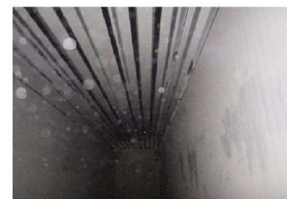
⑤PC鋼材、内面状況
