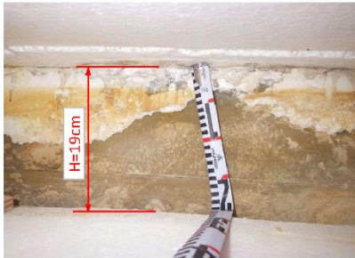
④ 橋座部状況
