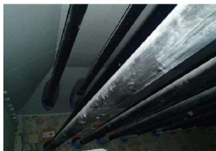
⑨PC貫通孔状況
