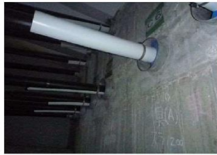
⑬PC貫通孔状況
