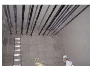
⑦隔壁1 壁面状況
