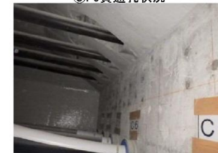
④PC貫通孔周辺状況
