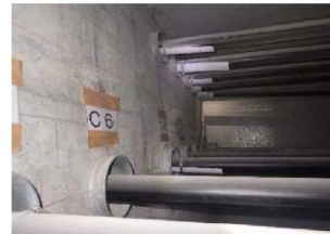
②PC貫通孔状況
