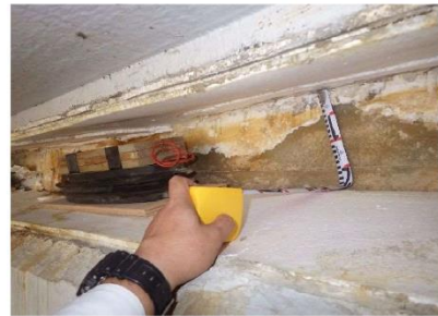
③ 橋座部状況
