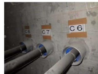
②PC貫通孔状況
