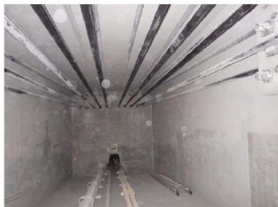
⑫隔壁2 壁面状況
