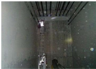
⑫隔壁、PC貫通孔状況
