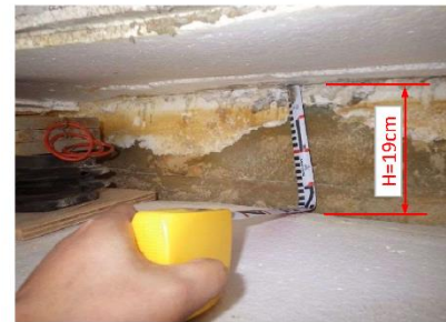
② 橋座部状況
