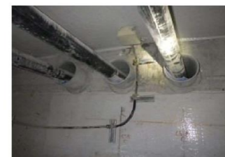
②PC貫通孔状況
