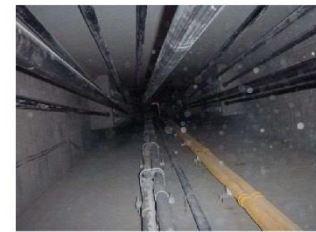
①隔壁状況
