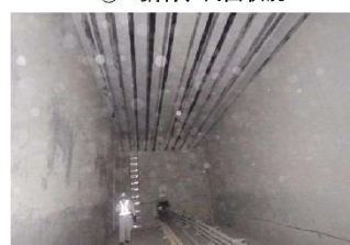
⑥隔壁1 状況
