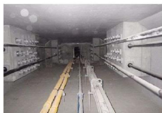
⑥隔壁状況
