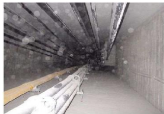
⑦内空状況
