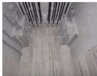
⑦P2部壁面状況
