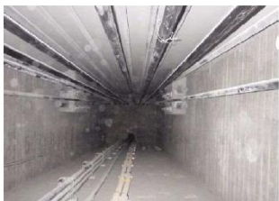
⑪ 内空状況
