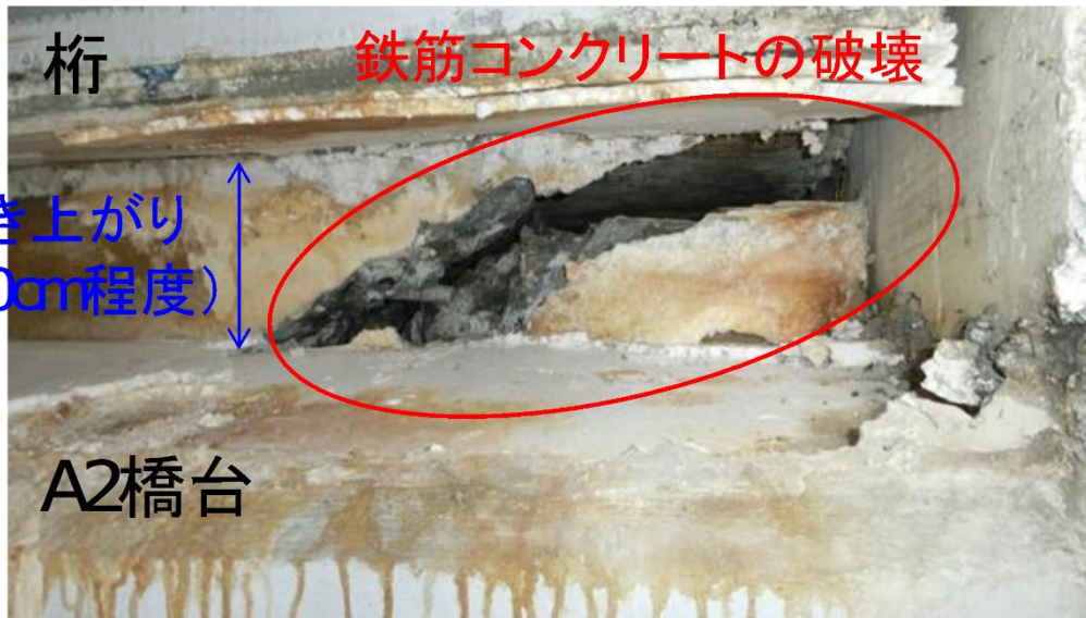
A2橋台前面の状況
