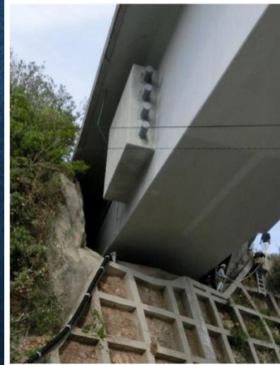
PC外ケーブル主桁側定着部
