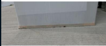
P2橋脚付け根部
