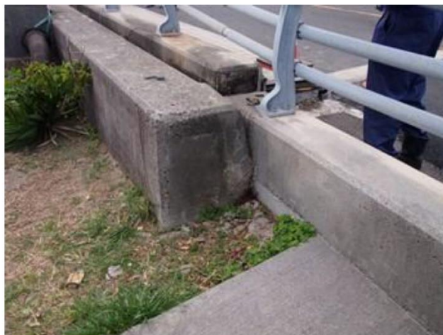
A2橋台周辺地山の状況
