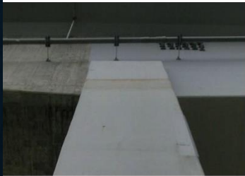
P2橋脚柱頭部
