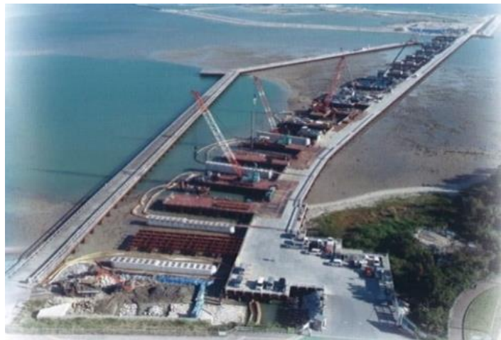
泡瀬連絡橋の全景
