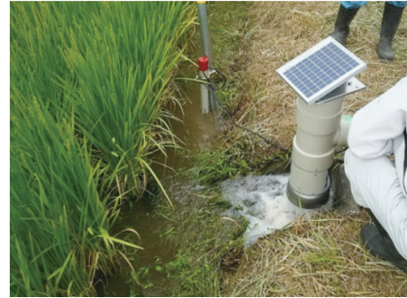
図 自動給水システム（パソコン等で簡単にほ場の水位が設定でき、入水管理が遠隔・自動で制御可能）
